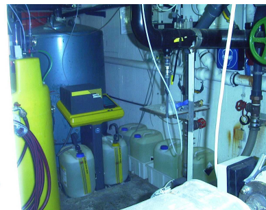
Lagerung von Gefahrstoffen
