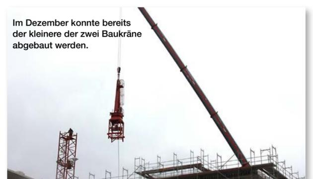
Im Dezember konnte bereits der kleinere der zwei Baukräne abgebaut werden.
