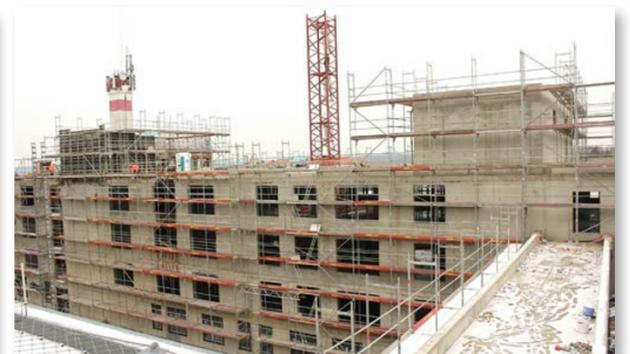
Im Dezember erreichten die Stahlbetonarbeiten Ebene + 5. Diese Etage für die Technik wird durch eine Stahlhülle ummantelt.
